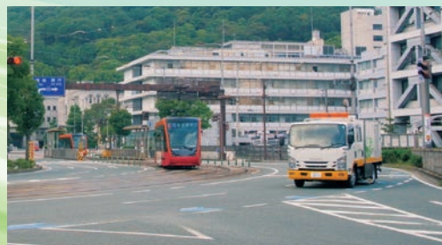
路面下空洞調査、埋設管路調査
